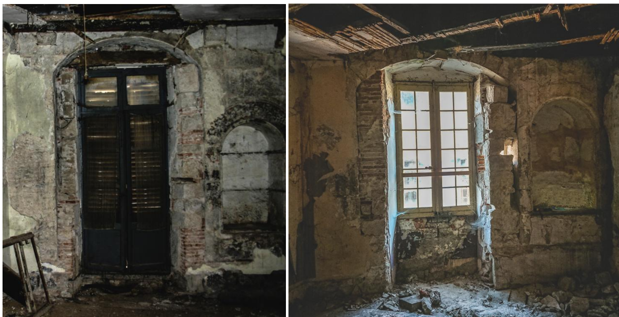
Fig.2 Embrasures . Vue intérieure de la baie A1.4 et de la baie A2.4 (on remarquera la moindre hauteur de cette dernière)
